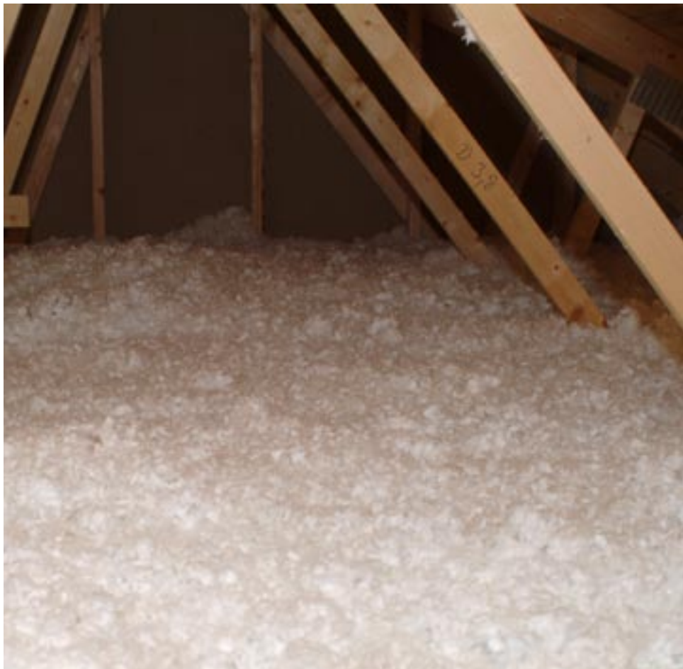
Vindsbjälklag isolerat med InsulSafe.
