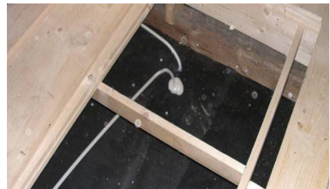
Bild 8. Att lufttäta befintliga vindsbjälklag är tidsödande och svårt men större otätheter bör alltid åtgärdas. Total lufttätet uppnås aldrig varför åtgärden endast är ett komplement till åtgärden att säkerställa god ventilation inomhus.
